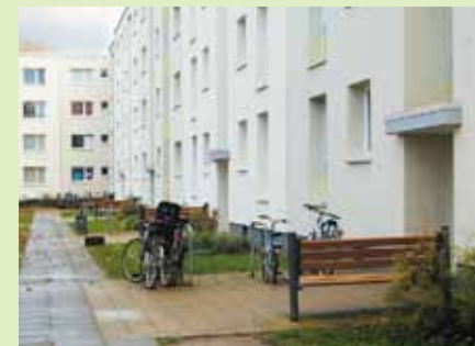
Überall neue Eingangsbereiche
